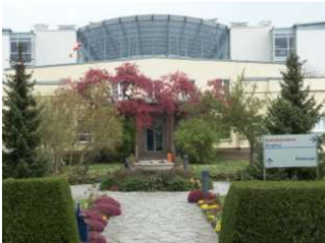
KH Bitterfeld (Außenansicht)
