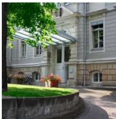
Eingangsbereich der RadGP am Diakonissenkrankenhaus
